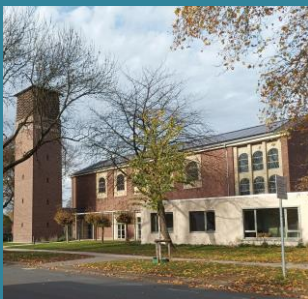
Kirche Herz Jesu Overbruch
